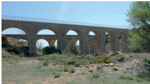
Viaductos de Fuensanta. En primer término viaducto de actual vía verde de Ojos Negros, al fondo el del ferrocarril Calatayud- Valencia, 2011. Rafa Salvador, Fondo CDR.
