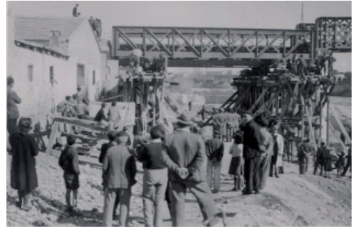
Sustitución de tramo metálico en el puente sobre el río Seco en la línea AVT, ca. 1915. Castellón. Biblioteca-Axiu de la Diputació Provincial de Castelló
