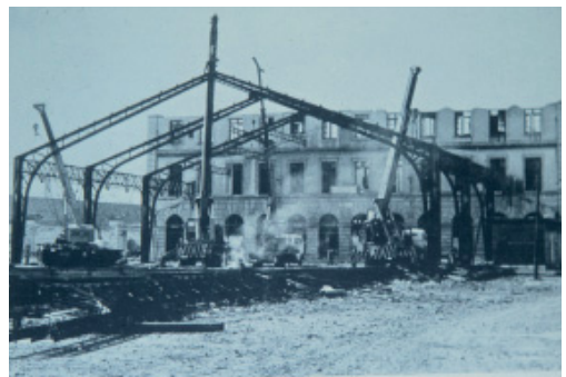
Derribo de la estación del Central de Aragón (Valencia-Alameda). Col. IAC.
