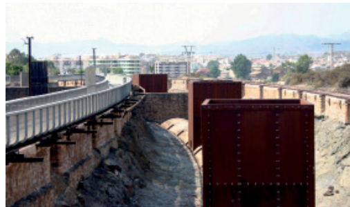
Silos horizontales y torres de ventilación
