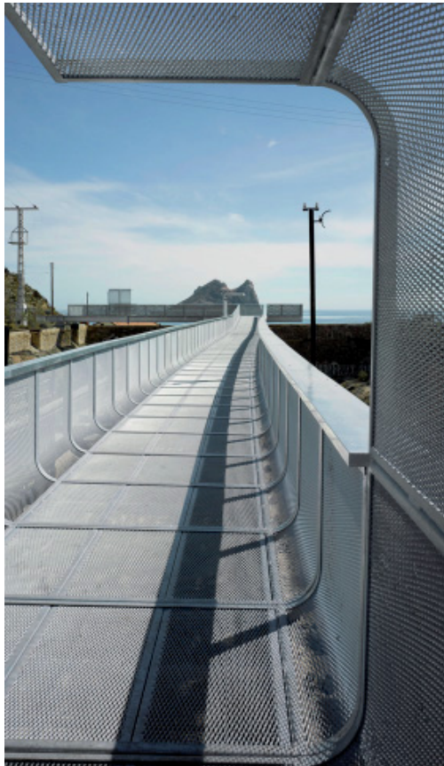
Pasarela sobre las vías existentes MIRADOR
