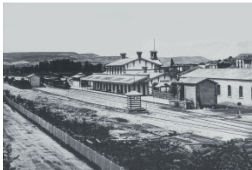
Vista interior de la estación de Logroño. Archivo de la Demarcación de Carreteras del Ministerio de Fomento, Ciudad Real.
