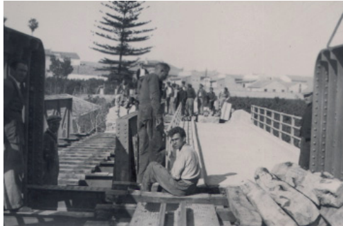
Trabajadores en el cambio del puente metálico sobre el río Seco en la línea AVT, ca. 1915. Biblioteca-Axiu de la Diputació Provincial de Castelló
