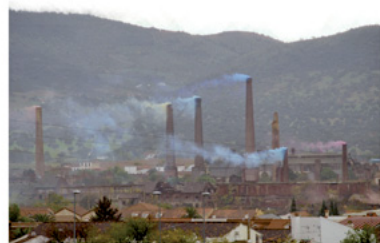
CHIMENEA EN HÉRZULETA, CÁDIZ.
