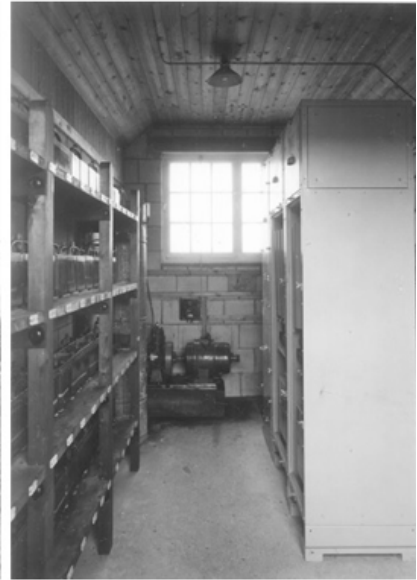
Vistas exterior e interior de una central rural UAX12 en Brockton (Reino Unido). Fuente: The UAX Project http://www.uax.me.uk
