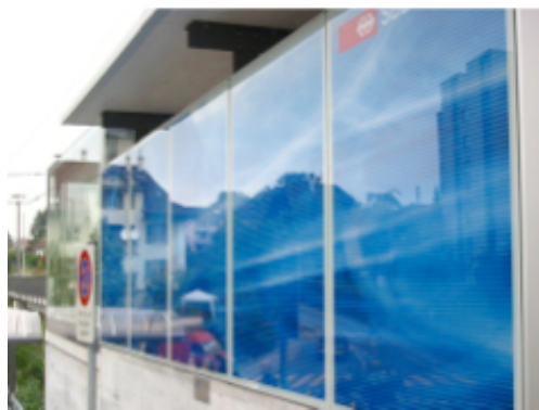
Paneles de cerramiento. Estación de Emmenbrücke-Gersag (Lucerna)
