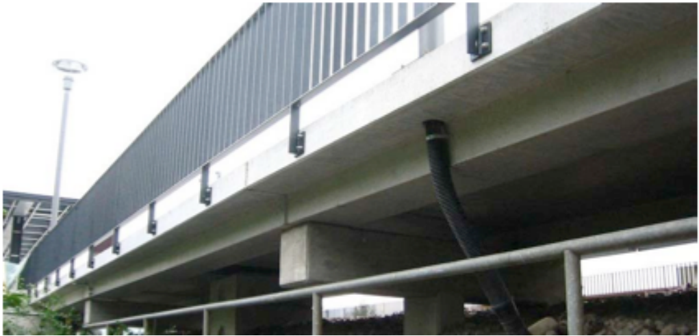
Andén prefabricado. Estación de Alpenblick , Zug
