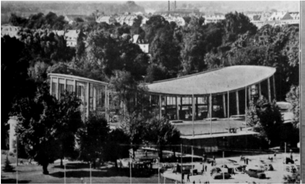
Sala de conciertos en Karlsruhe. Erich Schelling. 1954 (Figura 3)
