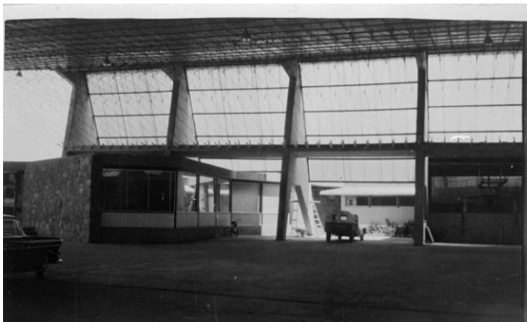
Fotografías de la Obra. Estación de Servicio "Los Enlaces". JYG. 1961 (Figura 16)
