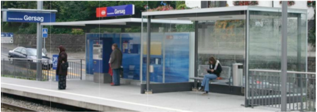
Refugio abierto junto a marquesina. Emmenbrücke Gersag (Lucerna)
