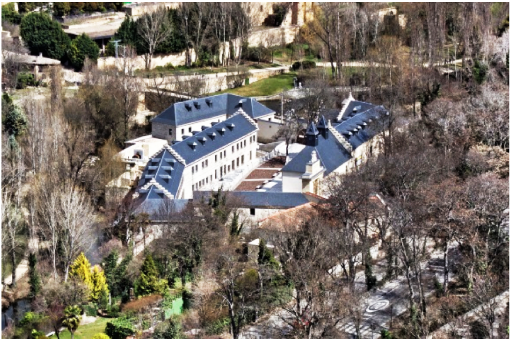
Fotografía del Real Ingenio durante la Rehabilitación (2011)
