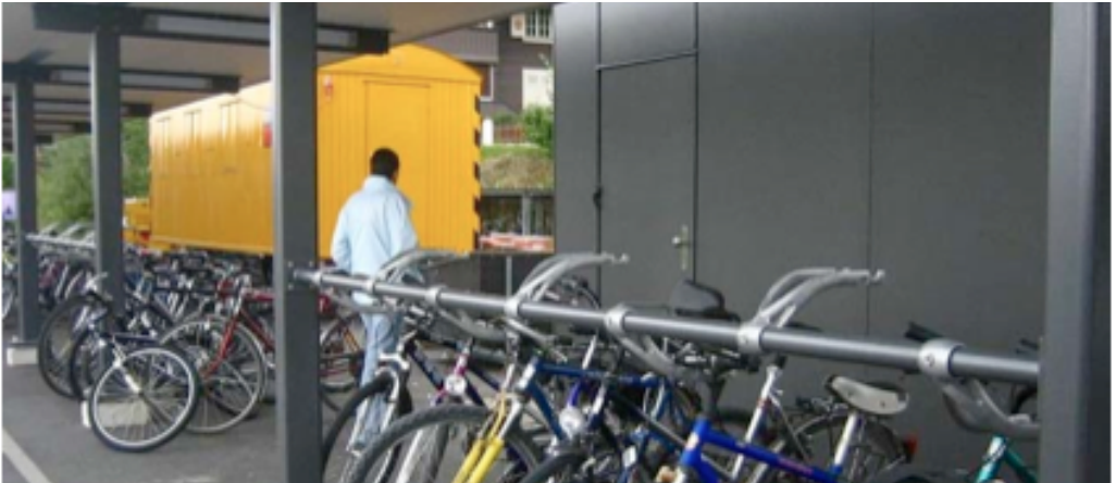
Marquesina-refugio de bicicletas. Estación de Ballwil, Lucerna
