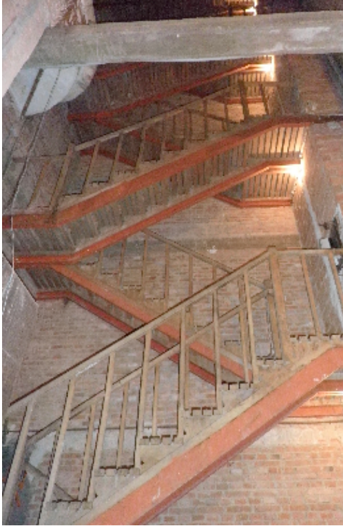
Interior de la torre de agua. Escalera de acceso al depósito y a cubierta. Fotografía de la autora. Enero 2014.
