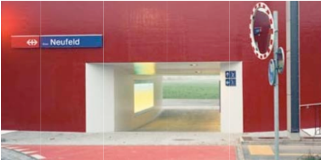
Paso subterráneo de Neufeld , Zug, diseñado según los principios del manual
