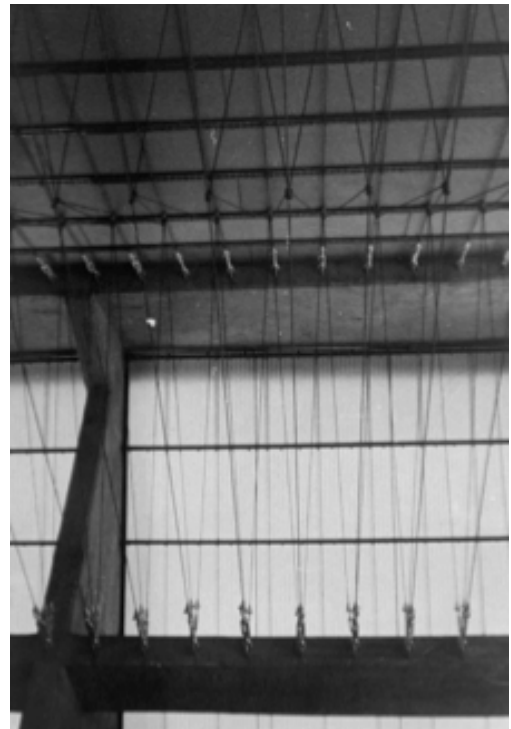
Fotografías de la Obra. Estación de Servicio "Los Enlaces". JYG. 1961 (Figura 14)
