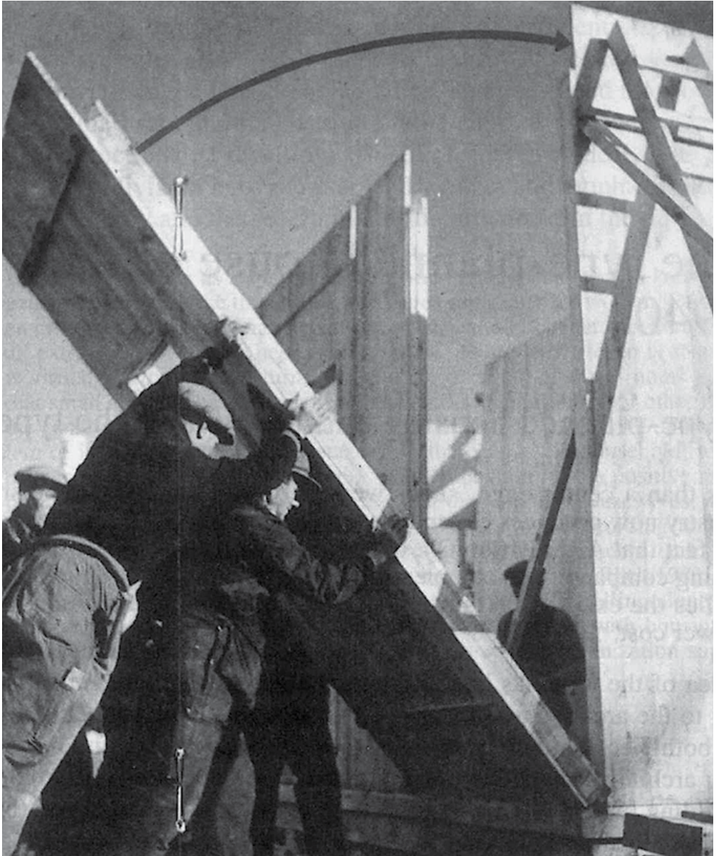
Construyendo una casa del sistema AA. En este caso se trata de un modelo de la segunda serie, compuesta por paneles de pared completos. Fuente: Saarikangas, Kirsi. 1993. Model houses for model families. Gender, ideology and the Modern dwelling. The type-planned houses of the 1940s in Finland. Suomen Historiska Samfundet, 1993
