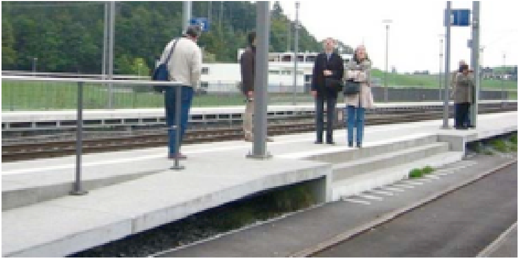
Andén prefabricado. Estación de Längenbold, Lucerna
