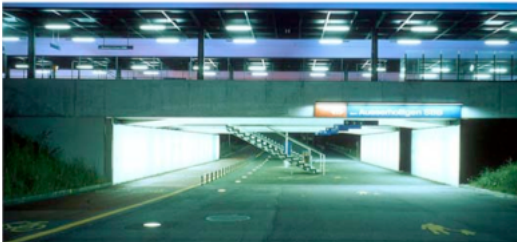
Paso subterráneo. Estación de Bern-Ausserholligen
