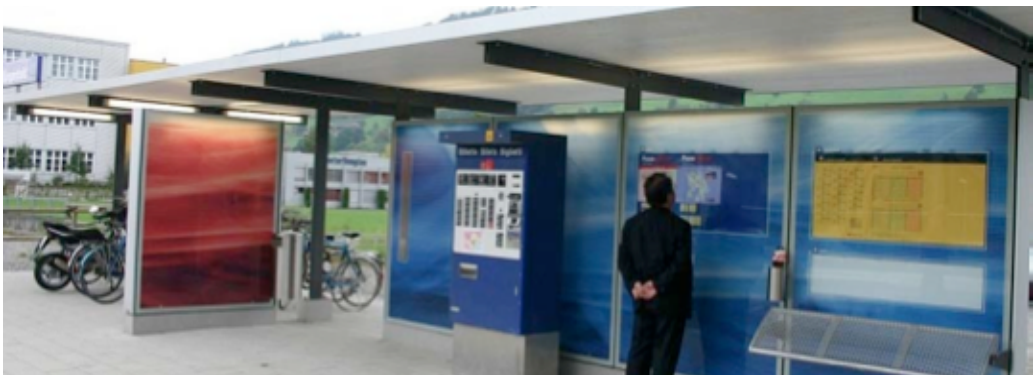
Marquesina. Estación de Längenbold (Lucerna)
