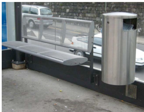
Banco y papelera anclados al zócalo del refugio. Estación de Emmenbrücke-Gersag
