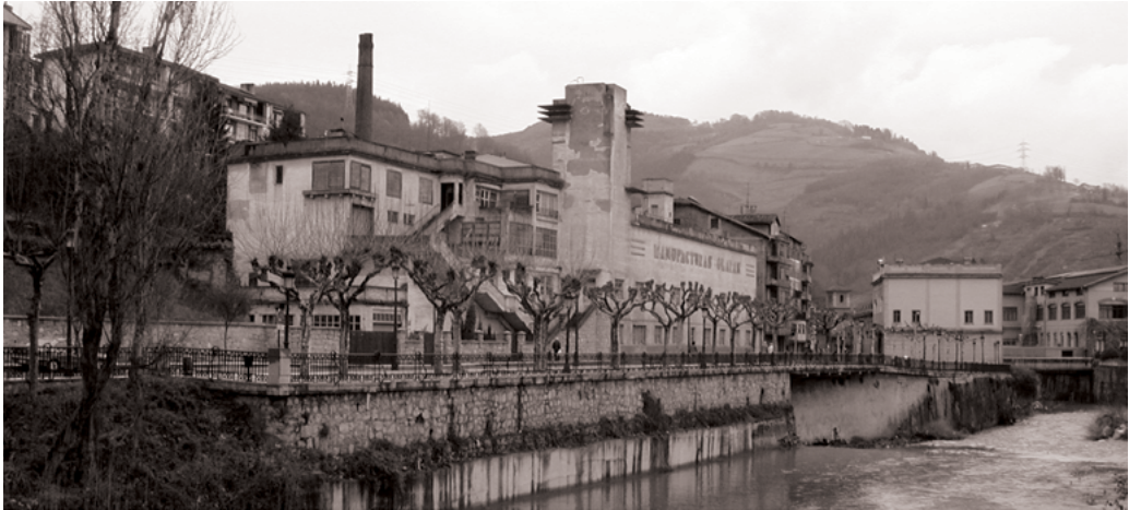
Detalle de la torre y rótulo en la fachada principal [Otamendi Irizar, I. 2012]
