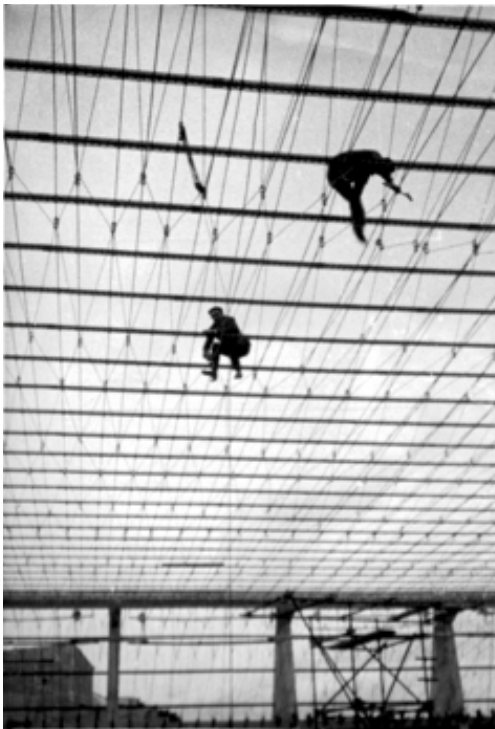
Fotografías de la Construcción. Estación de Servicio "Los Enlaces". JYG. 1961 (Figura 13)
