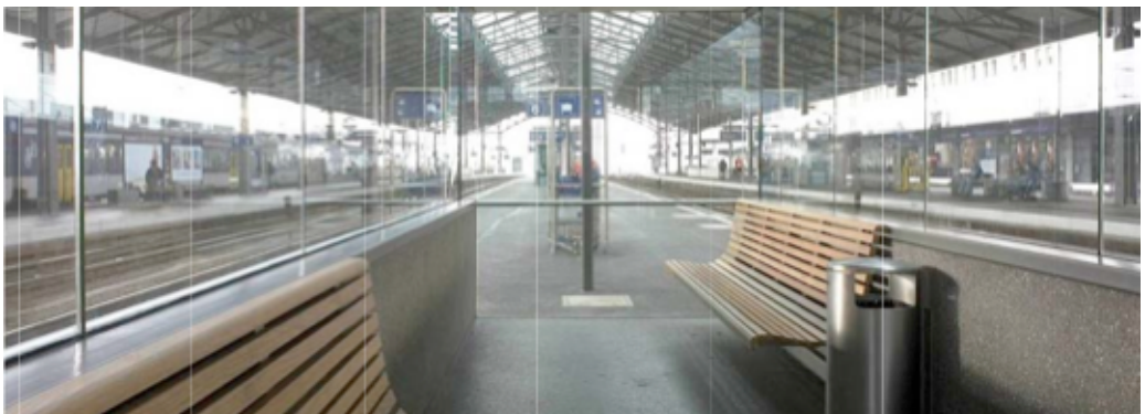
Refugio. Vidrio estructural. Estación de Lausanne
