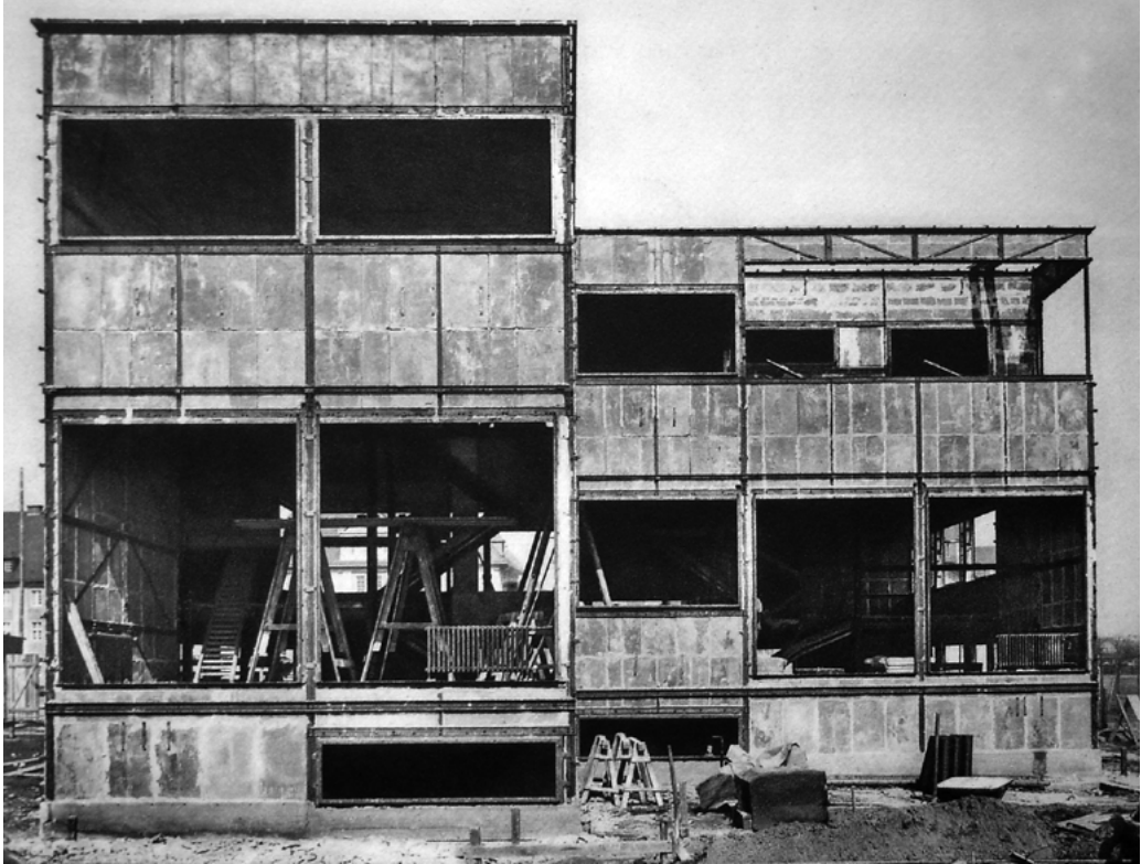
Las viviendas pareadas en construcción: cerramientos y carpinterías.
