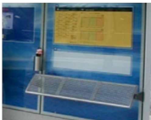
Papelera y apoyo isquiático anclado a la estructura de sujeción de los paneles. Información de horarios integrada en el panel. Estación de Längenbold
