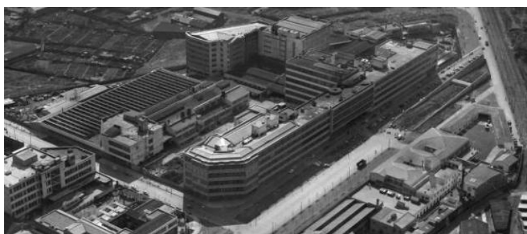
Figura 3 · Vista general del conjunto con el chaflán finalizado. Año 1965. Fuente Arxiu Nacional de Catalunya. Fondo TAF HELICÒPTERS SA. Codi ANC1-564-N-3985.
