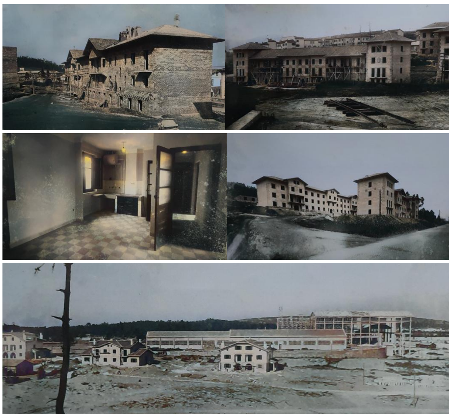
Figura 13. Viviendas y fábrica en construcción en Avilés
