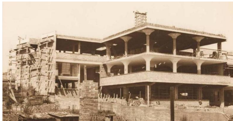
Figura 8 · Se puede observar los pilares con capiteles fungiformes y el inicio del montaje de la cubierta catalana. Fotografía de la ejecución de las fachadas. Fotografía propiedad de Material y Obras S.A. Autor desconocido. Fondo Olivetti Arxiu Nacional de Catalunya. 20 de marzo de 1942.
