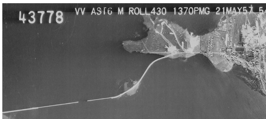
Figura 4. Viaducto de Arija a La Población con el tramo caído
