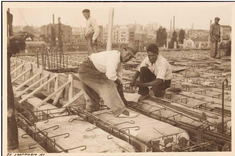
Figura 9. En esta imagen podemos observar el contraste entre la ejecución de un sistema constructivo innovador y el uso de elementos como un capazo de esparto o el uso de alpargatas para los operarios, que son más propios del mundo rural. Fotografía propiedad de Material y Obras S.A. Autor desconocido. Fondo Olivetti Arxiu Nacional de Catalunya. 24 de septiembre de 1941.
