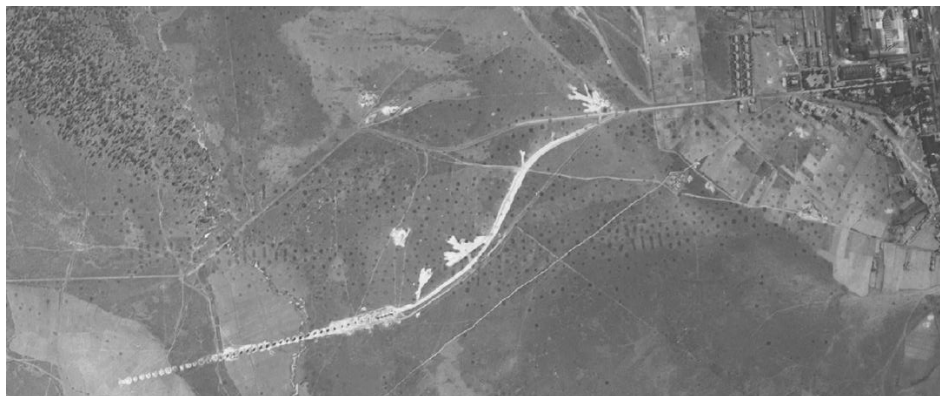
Figura 1. Viaducto de Arijá a La Población en construcción.
