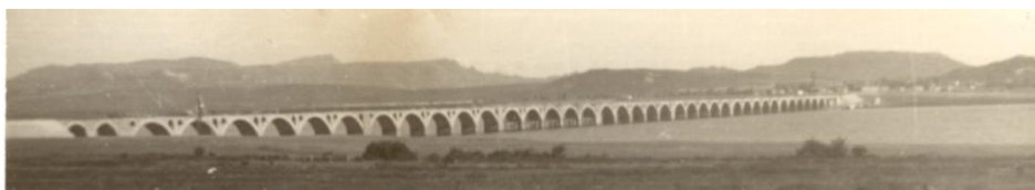
Figura 3. Puente Noguero antes del hundimiento (1952)
