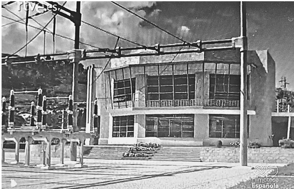
Figura 3. Oficinas de la Subestación de FENOSA. 09/09/1961. (Filmoteca Española, No-Do , episodio 976, 18/09/1961, minuto 02:05, disponible en RTVE Play: https://www.rtve.es/play/videos/no-do/not-976/1470303/# [consultado el 20/03/2026]).
