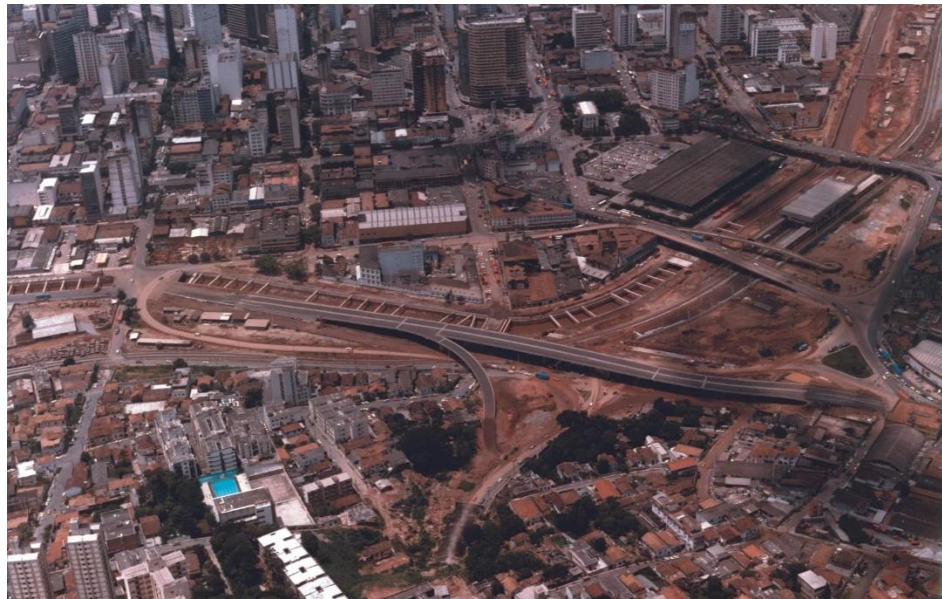
Figura 9. Construcción del Complejo Viario de Lagoinha, Belo Horizonte, 1985. (Procedencia: Acervo Mascarenhas Barbosa Roscoe Construções)
