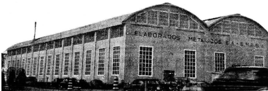
(Fig. 4) Exterior de la fábrica de EMESA antes de las ampliaciones ( La Noche , 09/11/1959: 3).
