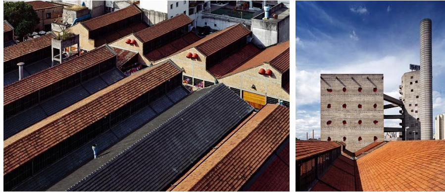
Figura 8. Vista aérea de las naves industriales originales del conjunto fabril (Instituto Bardi)
