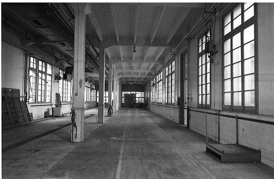
Figura 6 Nave vacía que anteriormente habría sido una parte de la Planta de preparación de rama de la Fábrica de Tabacos de Tarragona. En la parte izquierda, en el techo todavía está la instalación de extracción de aire, vapor, etc. en el suelo canalizaciones de recogida de agua. También hay en las paredes, aerotermos. (Archivo de Tabacalera)
