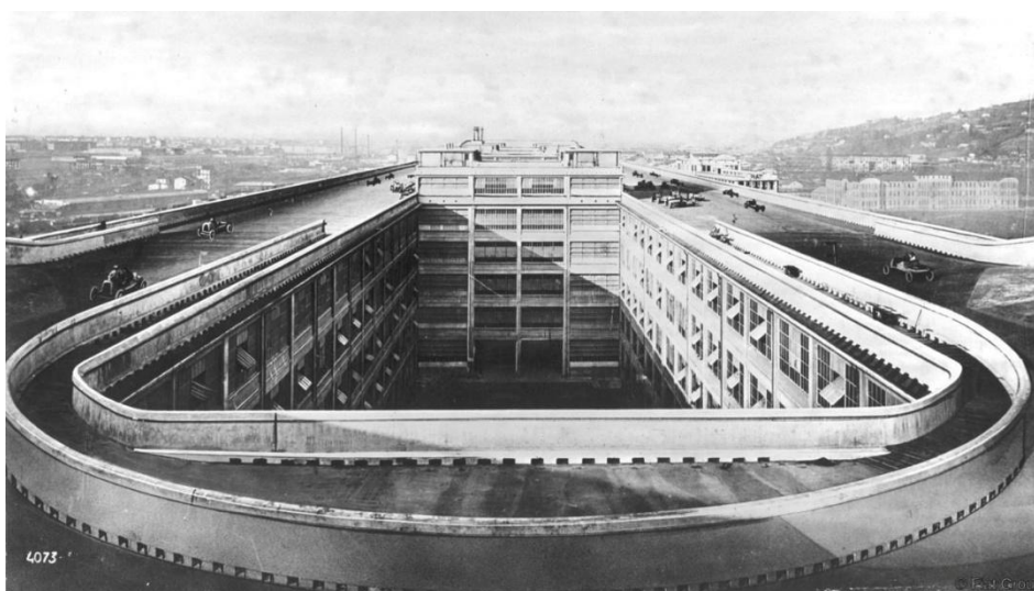
Figura 2. Fábrica Lingotto, Vista de la pista de pruebas superior, ca.1930 (Archivo FIAT)
