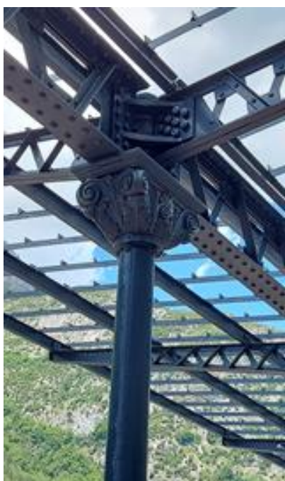
Figura 11. Capitel y estructura metálica restaurada. Marquesina E. Canfranc. Fuente: A. propio (2021).
