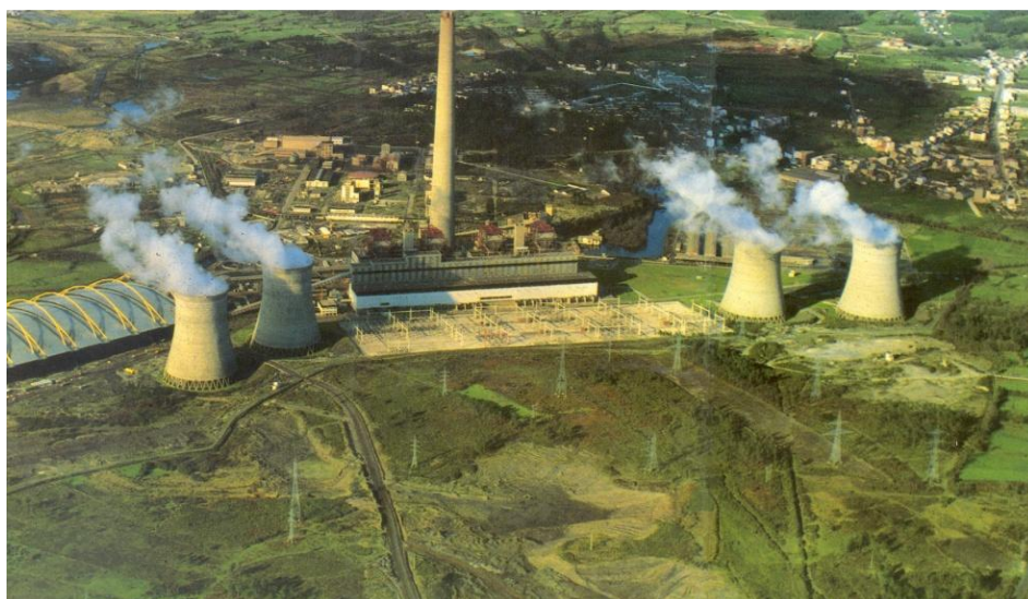
Figura 8. Vista general de la central térmica de As Pontes. En primer plano y en el centro, aparece la subestación de transformación (Fuente: Endesa generación).
