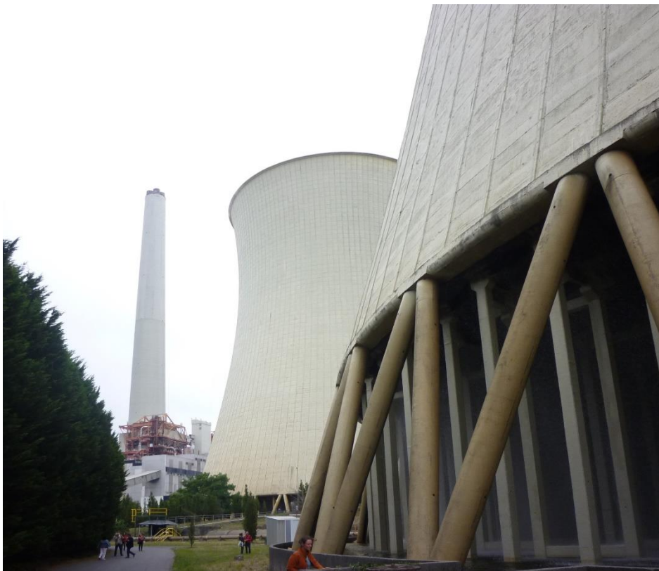
Figura 2. Torres de refrigeración y chimenea en central de As Pontes.
