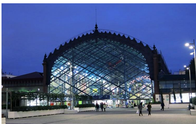
Figura 9. Vista fachada posterior E. Sevilla-Plaza de Armas. Fuente: A. Propio.
