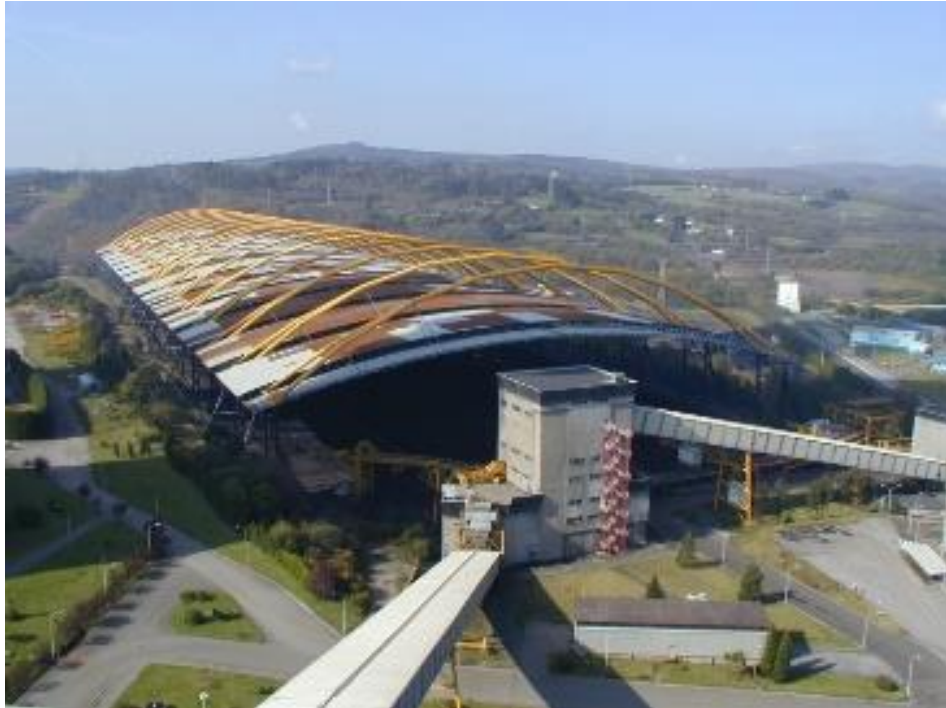
Figura 4. Parque de carbones para almacenamiento y homogenización. (Fuente: UPT As Pontes. Endesa).
