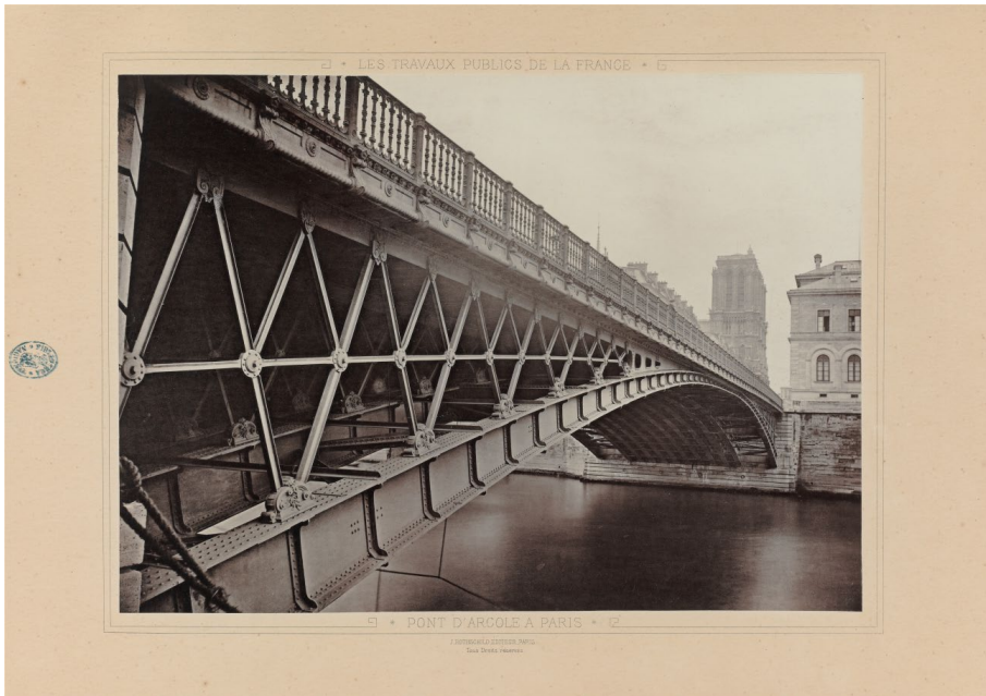
Figura 1. Pont d'Arcole (París), Les Travaux Publics de la France , Vol. 1, lam. 35.
