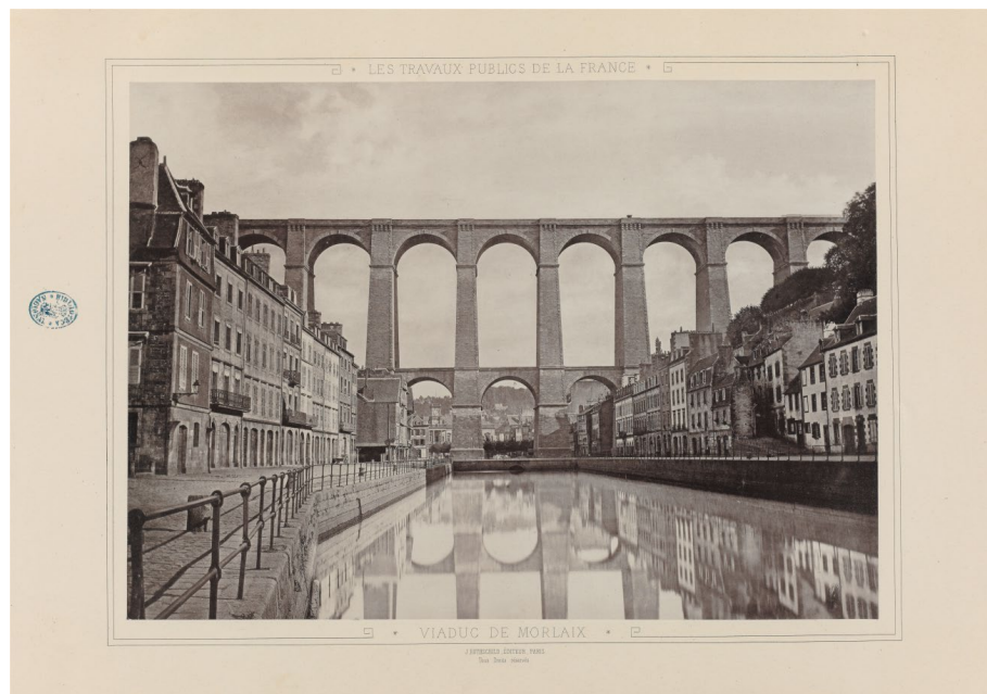
Figura 3. Viaduc de Morlaix, Les Travaux Publics de la France , Vol. 1, lam. 1.
