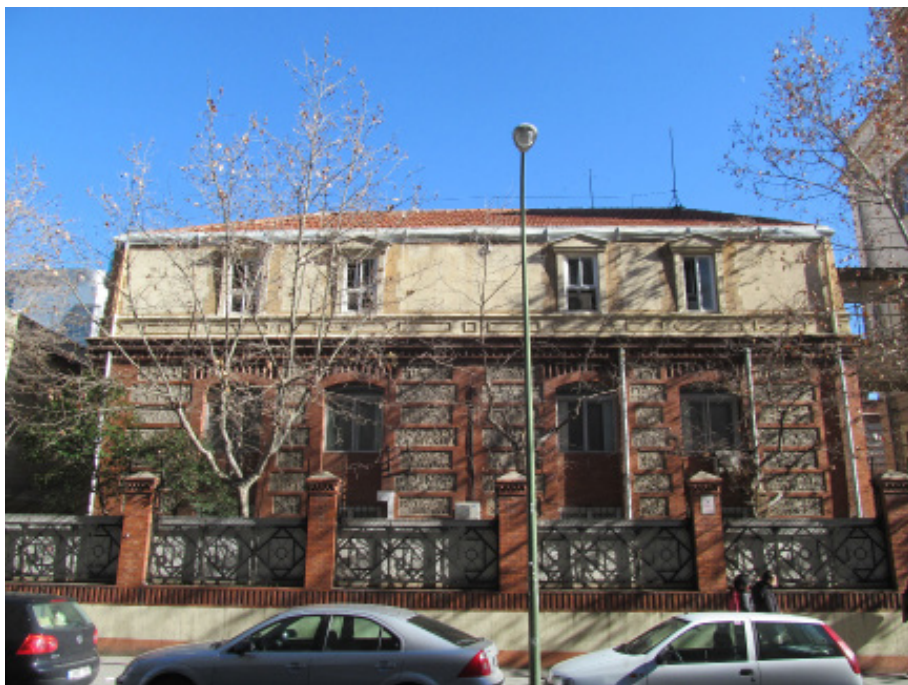
Alzado del pabellón angular destinado originalmente a alojar la Central Térmica visto desde la calle de Alonso Cano, 2015. Foto Álvaro Valdés
