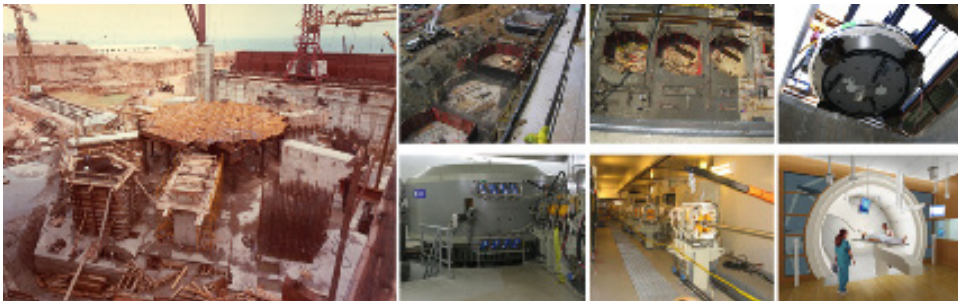
(Fotografía izquierda) Construcción del sótano de la Central Nuclear de Vandellòs-I (Fuente fotografía C.N. Vandellòs-I: ENRESA, Archivo Municipal Vandellòs i l'Hospitalet de l'Infant). (Fila superior) Proceso de construcción de un centro de protonterapia: Encofrado de muros de hormigón, construcción del búnker anti radiactivo y colocación del ciclotrón. (Fila inferior) Centro de Protonterapia en funcionamiento : Sala del ciclotrón en servicio, línea de haz de distribución de energía a las diferentes salas y sala de tratamiento con un gantry móvil (Fuente fotografías Protonterapia: The Perelman Center for Advanced Medicine, Hospital of the University of Pennsylvania)
