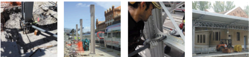
Fig. 04 | Imágenes del Proceso de Restauración de las Marquesinas
