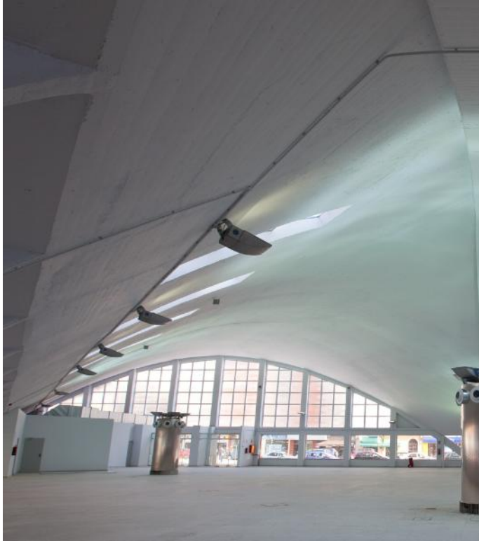
Mercado cubierto de Pola de Siero, 1931. Ingeniero Ildelfonso Sánchez del Río
